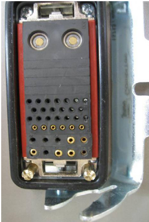
cos100719 Einbaubuchse Signal- und Ölleitung am Schaltschrank
