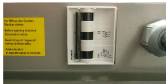
Sicherungsautomat, Gerätesicherung 3-polig C16A
