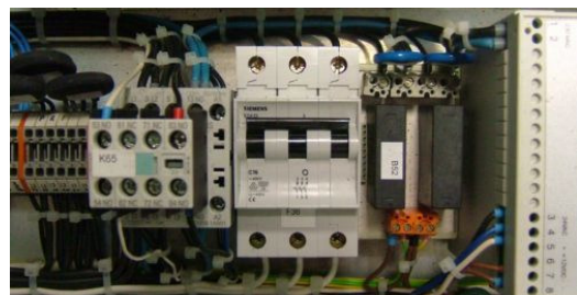
写真. 第2 ヒューズ 絶縁トランスフォーマー 3-軸 C16A
