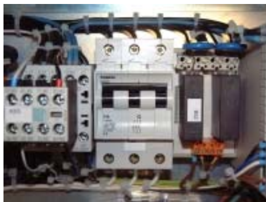
Вторичный предохранитель изолирующего трансформатора 3-полярный C16A
