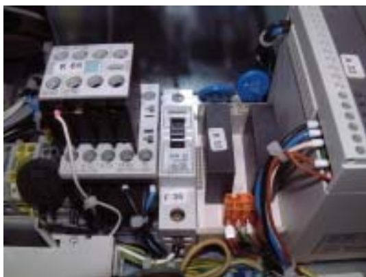
Вторичный предохранитель изолирующего трансформатора 1-полярный B16A
